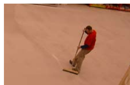
Mastertop 1250 avjämningsmassa läggs ut
