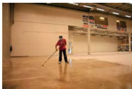
Ytan grundas med primer
